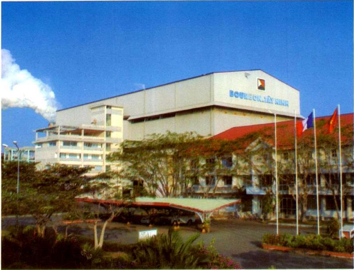
Nhà máy đường Bourbon - Tây Ninh
